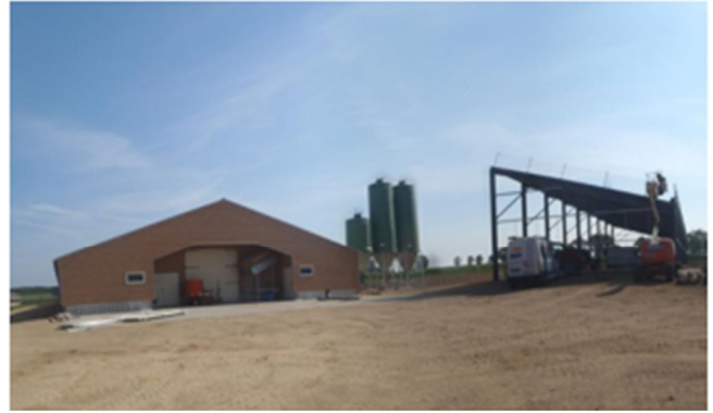
Vue du bâtiment B et du bâtiment de stockage
