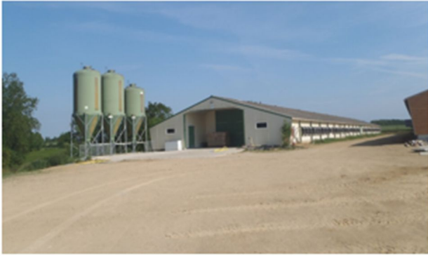
Vue du bâtiment A depuis la bergerie.
