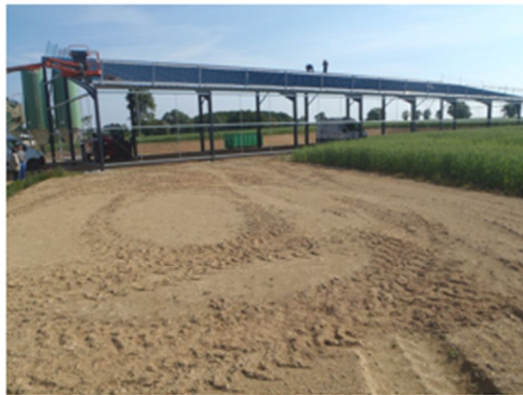
Vue du bâtiment de stockage alors en cours de construction depuis la plateforme de réserve d'eau incendie.
